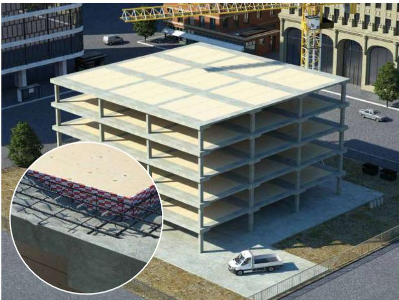
Die Verwendung des Systems TC FUSION mit Schrauben und Gewindestangen bietet außergewöhnlich hohe Vielseitigkeit für den Bau von Holz-Beton-Hybridkonstruktionen.
