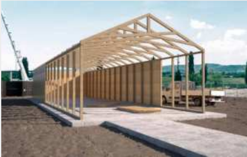
^ Befestigung von Holz-Fachwerken im Außenbereich.
