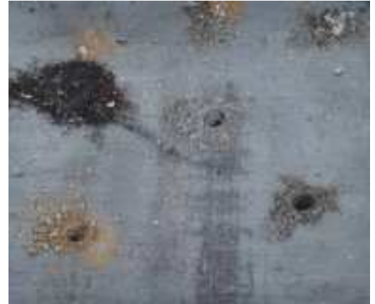
Beim Bohren angefallene Späne.
