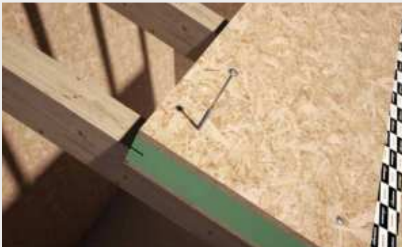
^ Befestigung von SIP-Platten mit 8 mm TBS-Schrauben.
