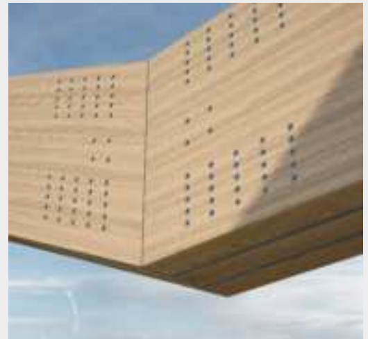
^ Angewinkelte starre Verbindung mit doppelter Innenplatte (LVL).
