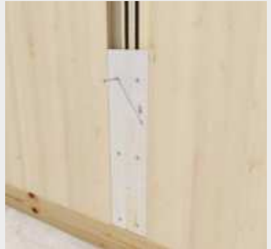
^ Befestigung von BSP-Wänden mit 6 mm HBS.
