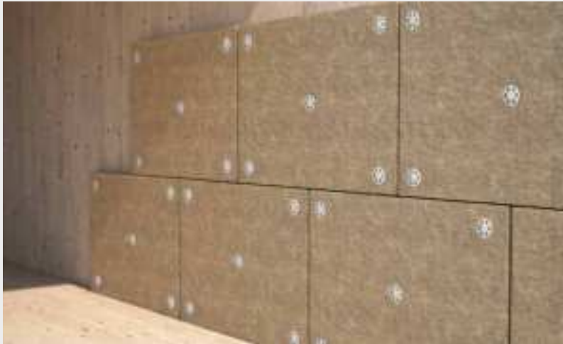
^ Befestigung von Wanddämmstoffen mit THERMOWASHER und HBS Durchmesser 8 mm.
