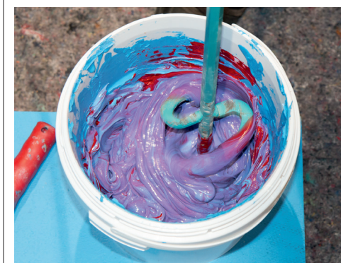
Mischen der Flüssigfolie bis homogene Farbe entsteht
