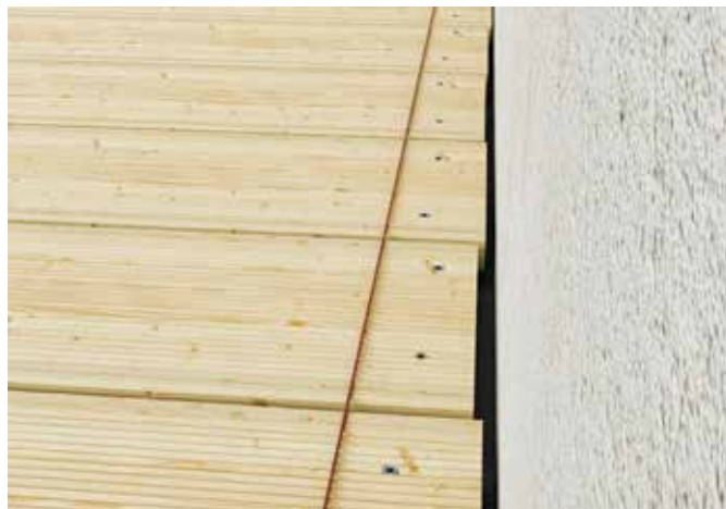
So sollte es nicht sein! Weder die Schrauben noch die Brettenden sind in einer Flucht.
