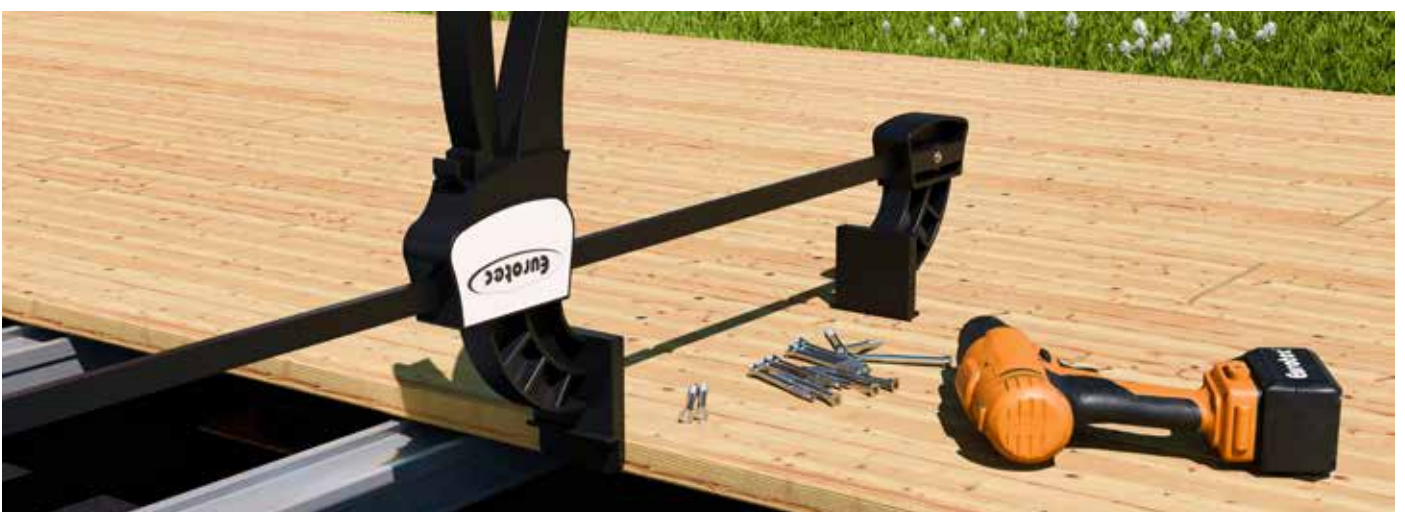
5. Montage des Terrassenbelags
