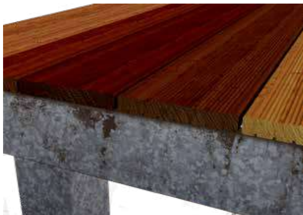
Auswaschungen aus Bangkirai, die sich nur durch eine konstruktive Lösung, z. B. Abtropfblech, verhindern lassen
