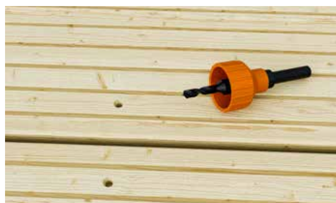
Verschraubung auf den Stegen der Nutenseite – Für eine saubere Verarbeitung empfiehlt sich das Vorbohren mit dem Versenker. Dabei ist der Geometrie des Schraubenkopfes Rechnung zu tragen.
