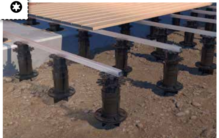
Erweiterung eines Terrassenfundaments mit dem Erdanker FLEXI.
