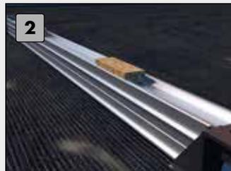
2 Die Schutzfolie vom Kork-Pad entfernen und in die Schiene einkleben.
