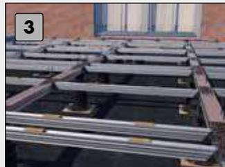
3 Die Schienen gleichmäßig verteilen, sodass die Steinplatten optimal unterstützt werden. Mit der mitgelieferten Aluminium Profilbohrschraube Ø 4,2 x 35 fixieren.
