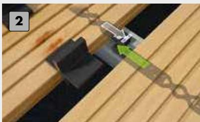
2 Schieben Sie die Terrassengleiter unter die davorliegenden Dielen. Mit einem Fugenkreuz erhalten Sie die perfekte Fuge.
