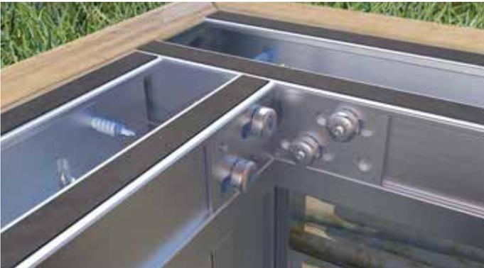
**12** Die Terrassendielen werden parallel zur Hausfassade verlegt. Begonnen wird an der Hausfassade mit der ersten Diele. In unserem Beispiel haben wir eine sichtbare Befestigung gewählt und die Dielen mit der Eurotec Profilbohrschraube an den Alu-Systemprofilen EVO angeschraubt. Als Hilfsmittel empfehlen wir den Drill-Stop, die Distanzklötzchen und die Spannzwinde.
