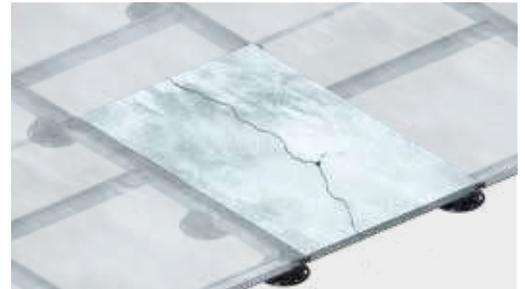
Erhöhte Bruchgefahr einzelner Platten aufgrund fehlender Stützprofile.
