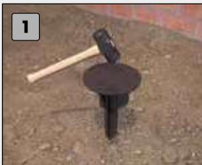
1 Erdanker mittels Hammer in den Boden schlagen.
