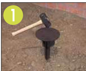
1 Erdanker mittels Hammer in den Boden schlagen.
