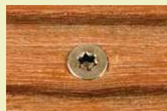
Vorbohren + Terrassotec-Schraube
