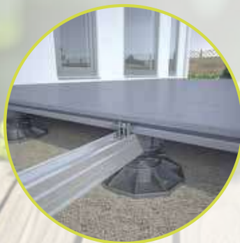
Nicht sichtbare Befestigung mittels Systemhalter EVO Light
