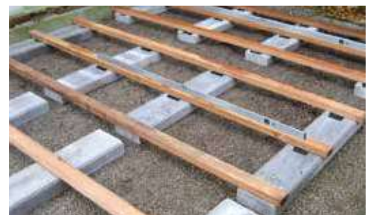
Rolfi-Abstandhalter in Kombination mit Holzunterkonstruktion.
