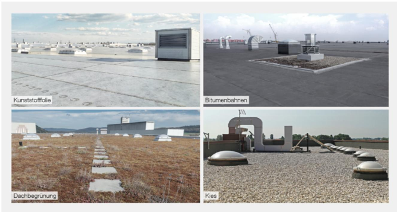
Die Dächer werden mit Bitumenbahnen oder Kunststofffolien durch Kleben oder Verschweißen abgedichtet. Eine zusätzliche Sicherung kann durch eine Dachbegrünung oder Kies erfolgen.
