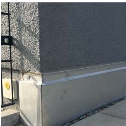
IPSD installiert mit Spenglerschraube
